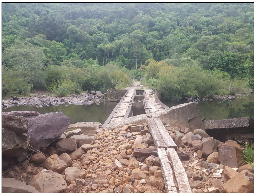
Figura 11 – Estrutura da ponte atual.
